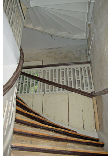
Abbildung 16: Das Heimatmuseum Raunheim vor der Sanierung. Quelle: ProjektStadt
