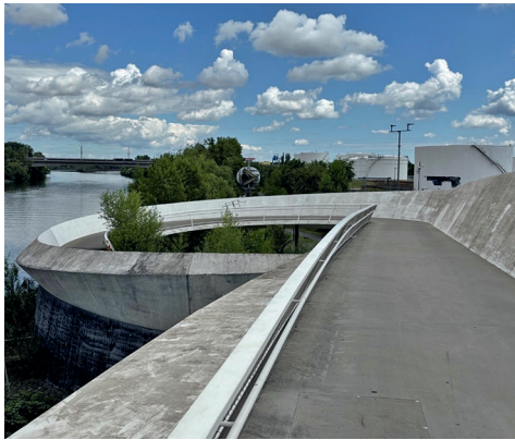
Abbildung 7: Ölhafenbrücke. Quelle: ProjektStadt
