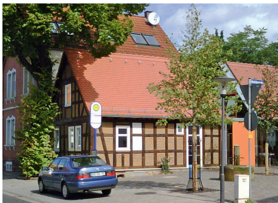
Abbildung 19: Das Schalle-Haus nach der Sanierung. Quelle: ProjektStadt
