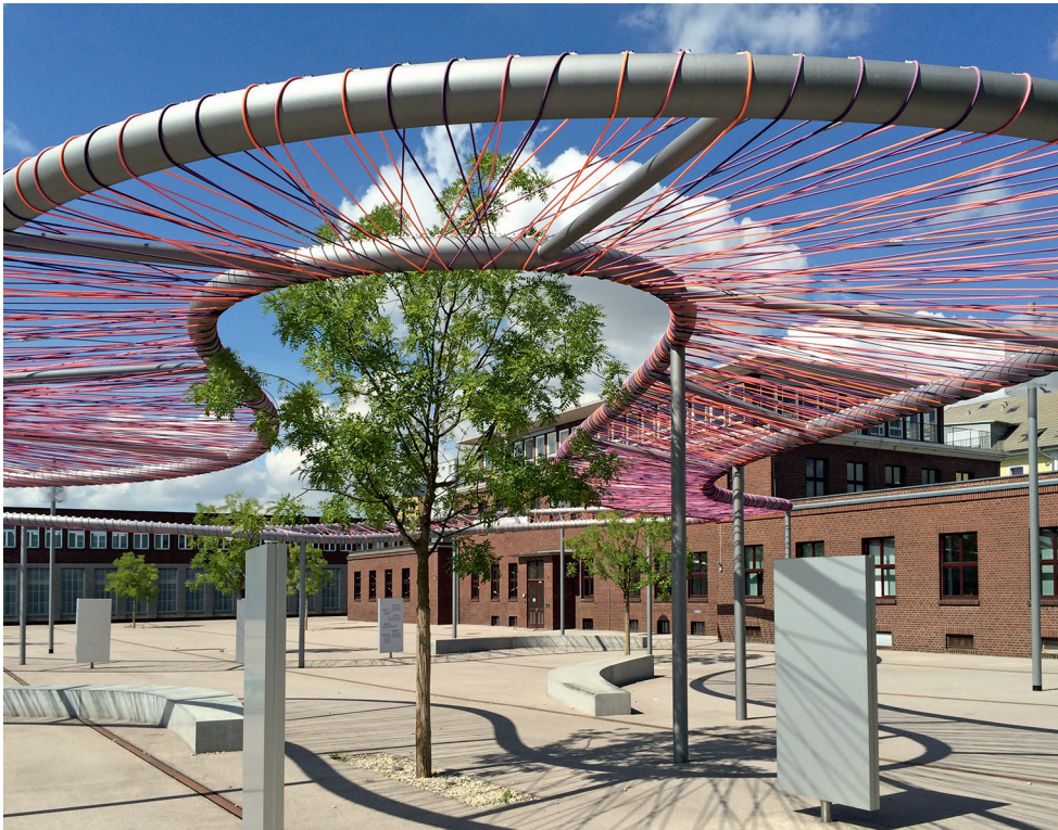
Abbildung 22: Der fertiggestellte Graf-de-Chardonnet-Platz. Quelle: ProjektStadt
