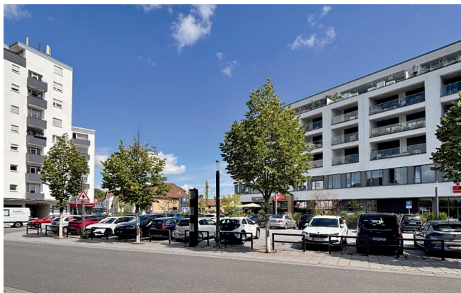
Abbildung 23: Der fertiggestellte Sandhügelplatz. Quelle: ProjektStadt
