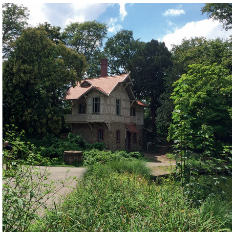
Abbildung 14: Palais Verna in Rüsselsheim am Main. Quelle: ProjektStadt
